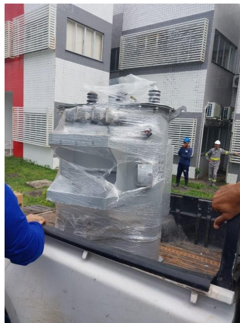
Figura 1. Fornecimento do transformador trifásico de 225 KVA, AT 13,8 kV, BT 220/127 V, com isolamento a óleo mineral.
