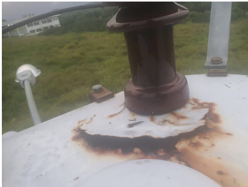
Figura 1. Carcaça danificada do transformador do alojamento feminino do Campus São Cristóvão.
